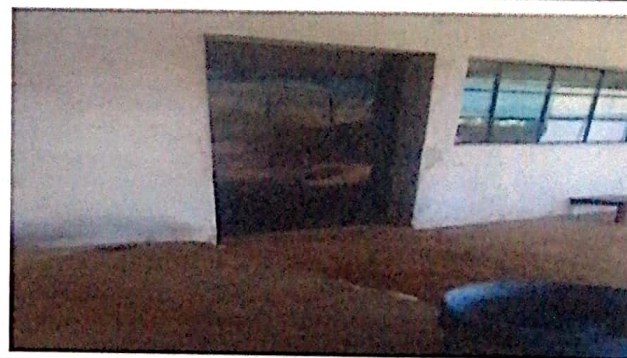
Foto 4: Instalacion de puerta de metal del aula del centro estudiantil
