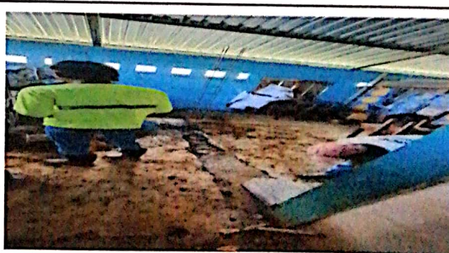
Foto 6: Observandose los diferentes procesos realizados en el aula, cambio de laminas troqueladas, habiliación y instalación de puertas de metal
