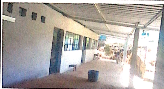
Foto 2: vista Frontal del establecimiento, cambios de costaneras y laminas troqueladas del corredor
